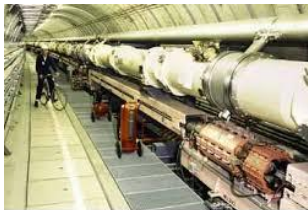
Versnellertunnel HERA Boven de protonenversneller met supergeleidende magneten (rond), onder de elektronenversneller (rechthoekig)
